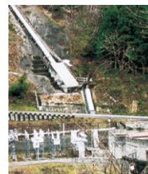
新内川第二発電所 最大出力 3,000kW
