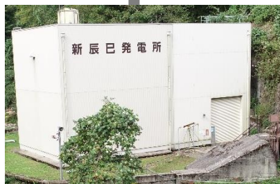
新辰巳発電所 最大出力 6,200kW
