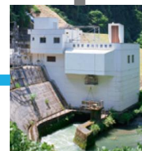
新内川発電所 最大出力 8,000kW
